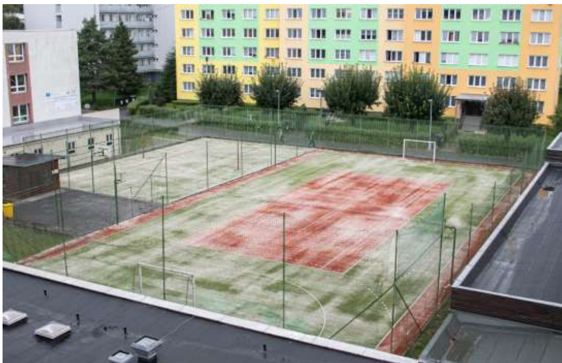
Nový stav po kompletní regeneraci - celkové vyčištění s násypem nového křemičitého písku
