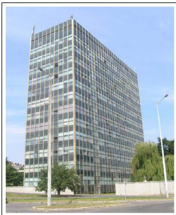
Obr. 1 Pohled na jihozápadní část Katedrového objektu MFF Univerzity Karlovy v areálu V Holešovičkách 2, Praha 8
